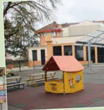
Création d'un préau
