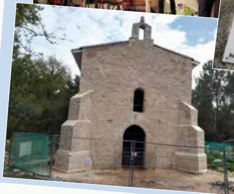
Rénovation de la chapelle de Brax
